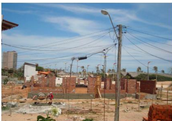
Figura 10 - Obras da Construção da Capela
