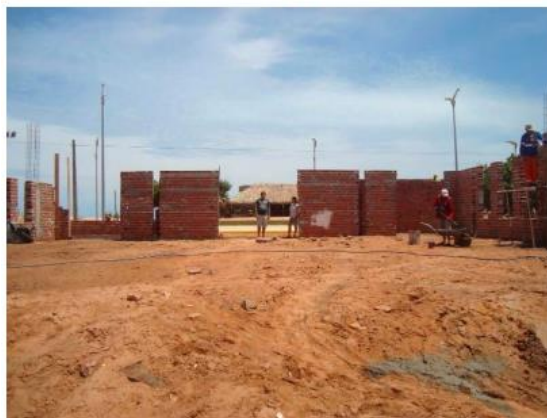
Figura 11 - Obras da Construção da Capela
