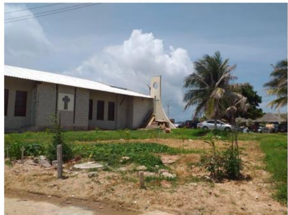
Figura 15 - Levantamento e reconhecimento da área in loco Terreno
