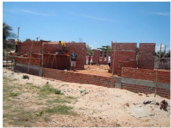
Figura 13 - Obras da Construção da Capela
