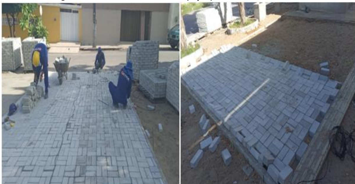
Figura 10 – Assentamento manual de peças pré-moldadas de concreto
