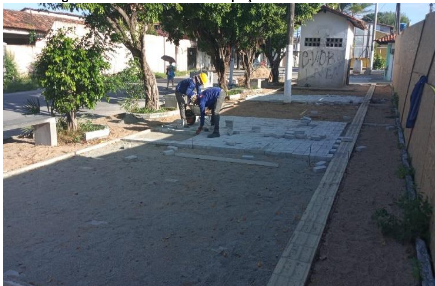
Figura 09 – Assentamento das peças sobre a base
