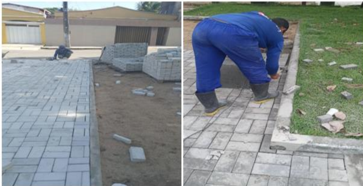
Figura 11 – Acabamento de piso intertravado
