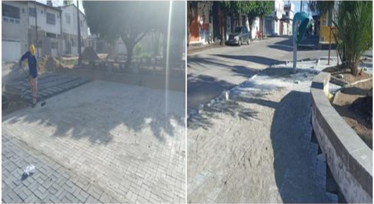
Figura 12 – Rejuntamento com pó de pedra
