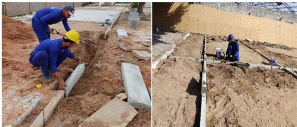
Figura 08 – Assentamento de meio fio pré-moldado
