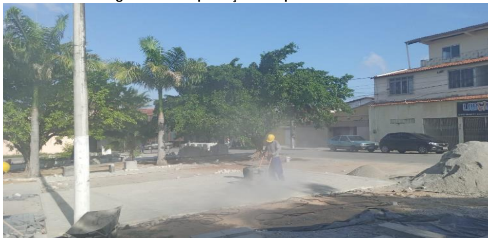
Figura 13 – Compactação com placas vibratórias
