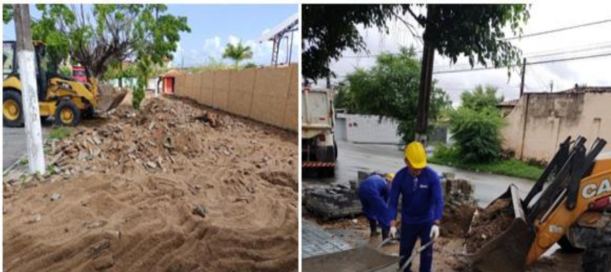
Figura 07 – Raspagem e limpeza do terreno
